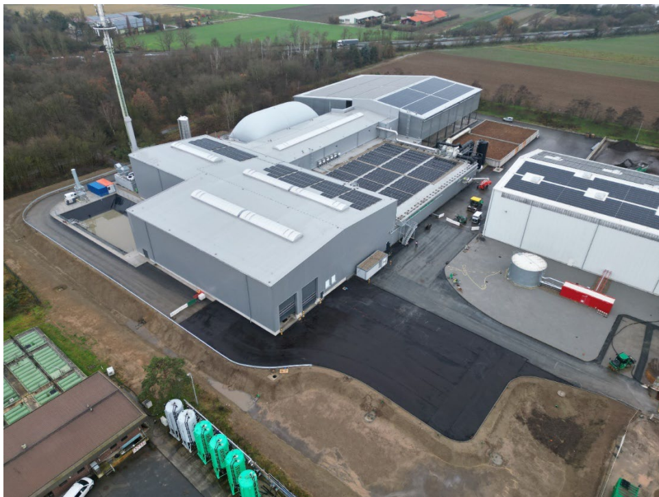
Übersicht Baufortschritt BVA; Foto: AWS am 09.12.2025
