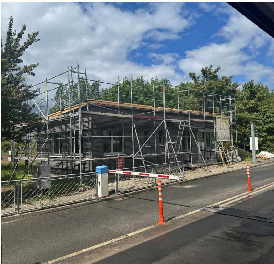
Neubau Empfangspavillon im Abfallzentrum Büttelborn; Foto: AWS
