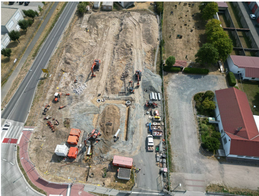
Gelände WSH Stockstadt nach Abriss 31.07.2026; Foto: AWS
