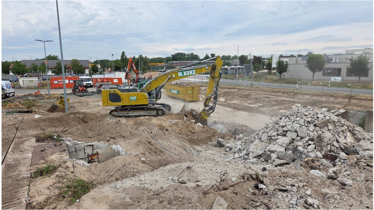
Abrissarbeiten WSH Stockstadt: 06.07.2026; Foto: AWS
