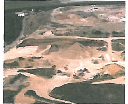
Sie gehört noch heute zu den modernsten Deponien in Europa. Ende der achtziger Jahre wird das Abfallzentrum Büttelborn gebaut und 1990 eröffnet.
