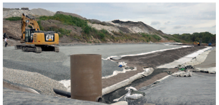
Die Bagger sind auf der Riedwerk-Deponie im Dauereinsatz
